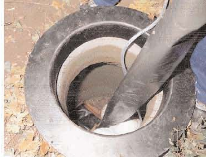
Impregnirani GFK-liner uvlači se kroz šaht
